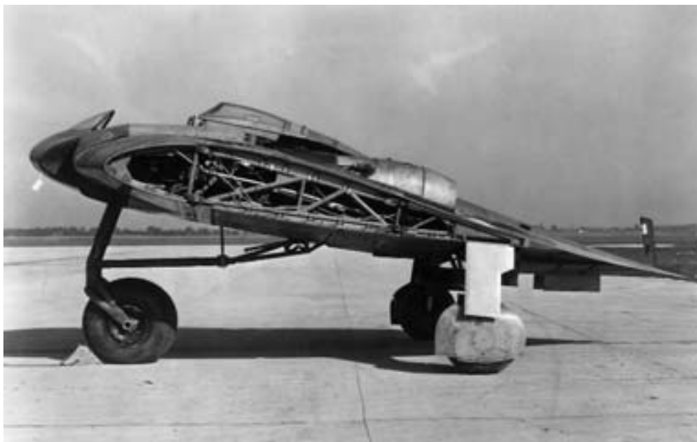
Полусобранный Но.IX (Go.229), захваченный американскими войсками.
