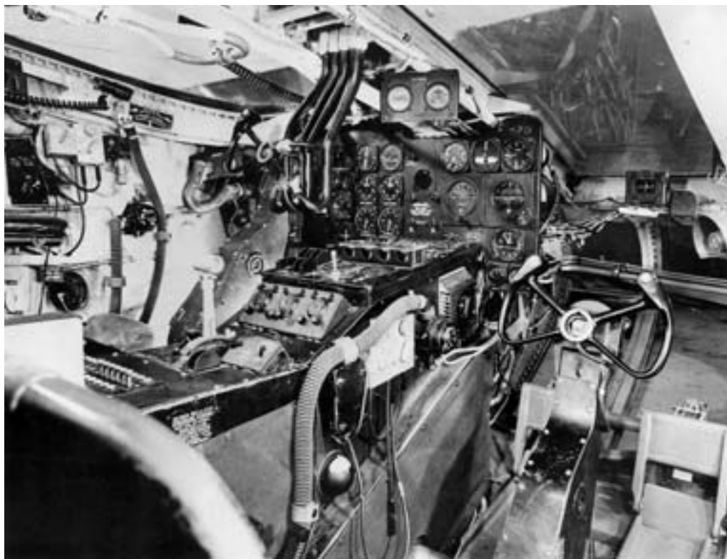
Кабина экипажа XB-35.
