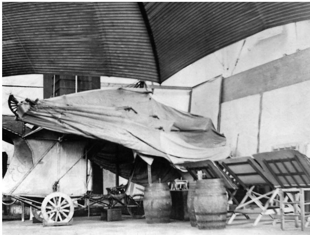
В мастерской К.Адера. Это единственная сохранившаяся фотография самолета "Эол" (показан со сложенным крылом). На переднем плане — крыло "Авиона-3".
