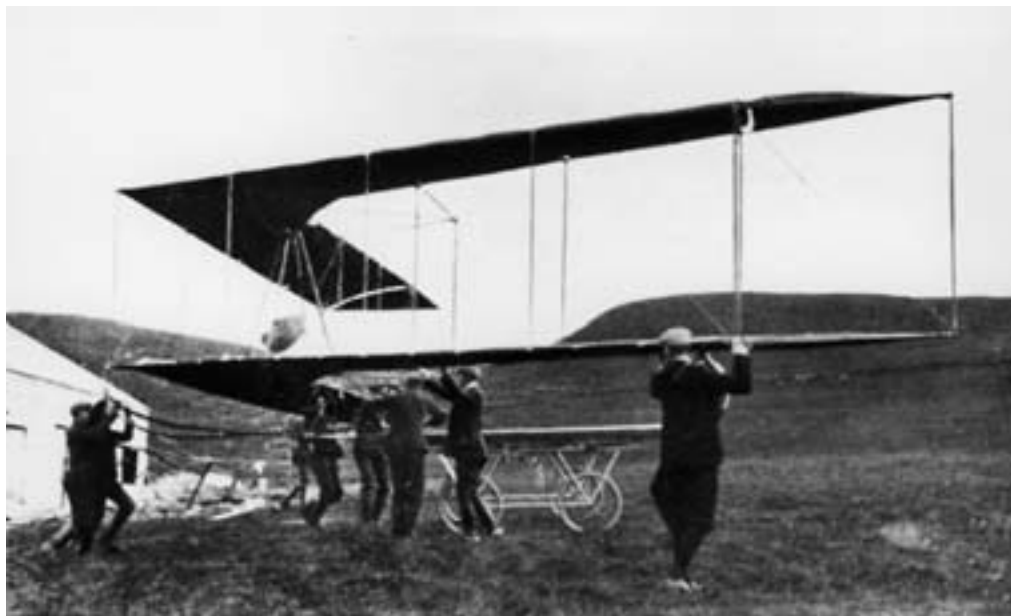
Планер Д.Данна D.1 перед полетом. Для старта он был установлен на отделяемую в воздухе тележку.
