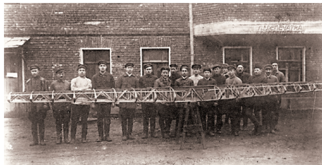
Каркас крыла АНТ-2 и участники постройки самолёта во дворе дома 17 по ул. Радио
