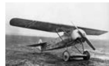
Истребитель Фоккер D 8 — первый серийный самолёт с фанерной обшивкой крыла
