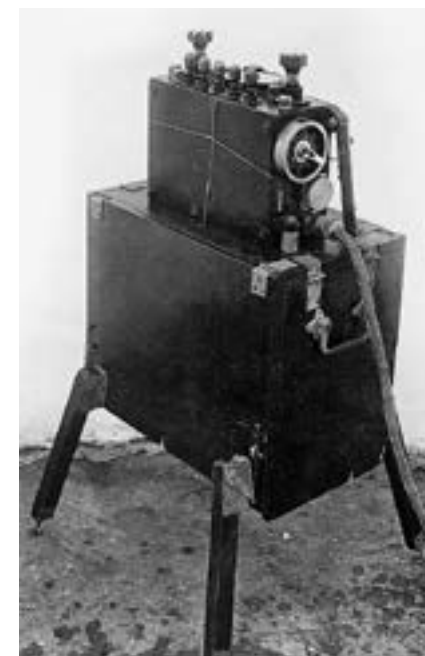
Аппаратура для передачи сигналов с земли на самолёт
