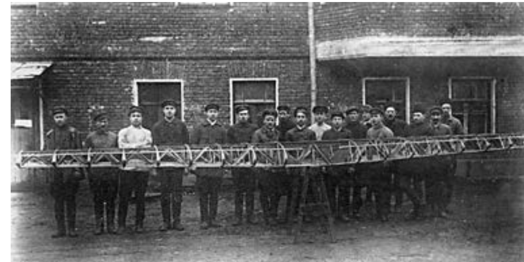
Каркас крыла АНТ-2 и участники постройки самолёта во дворе дома 17 по ул. Радио
