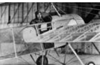
Фоккер Е 3 с прозрачной обшивкой крыла и задней части фюзеляжа — попытка создать невидимый истребитель в годы Первой мировой войны
