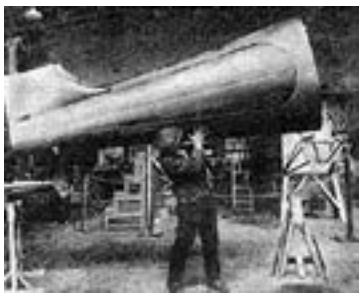
Демонстрация легкости конструкции из электрона
