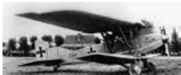
Штурмовик Юнкерс J4 — первый самолёт дюралюминиевой конструкции
